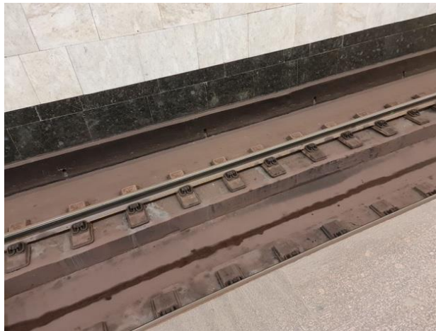
Рис. 3. Конструкция LVT на станции метро Свиблово.
